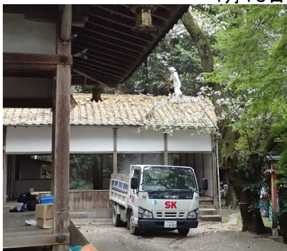
東畑神社の解体工事
